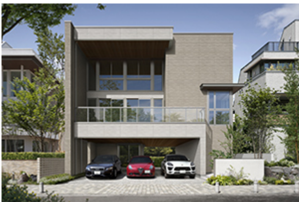
高強度梁により、3台並列駐車のパルトインガレージ計画が可能
