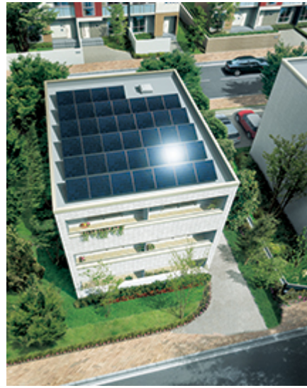
据え置き型太陽光パネル
