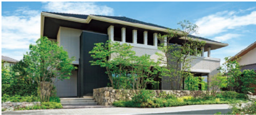
鉄骨2階建て住宅「イズ・ロイエ」
