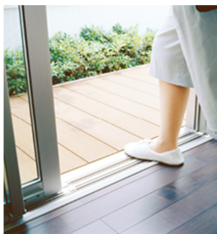
フルフラットサッシ、フルフラットバルコニー (第5回キッズデザイン賞受賞)
