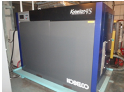
コンプレッサーの更新
