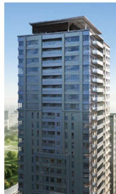
全戸にエネファームを設置した「グランドメゾン上町台 ザ・タワー」
