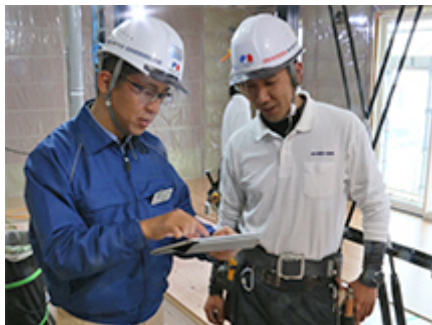
施工現場でのIT活用（工事監理者、施工者等に配布したスマートデバイスによる、施工マニュアルの周知、正確な施工や工期管理の実現）
