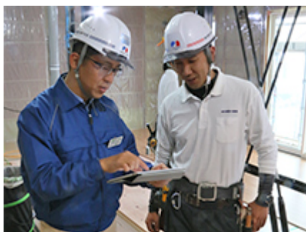
施工現場でのIT活用（工事監理者、施工者等に配布したスマートデバイスによる、施工マニュアルの周知、正確な施工や工期管理の実現）
