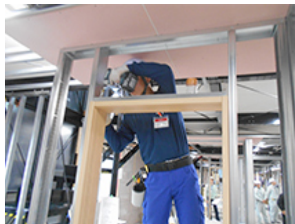
「内装施工コース」修了実技試験 (出入枠の施工)
