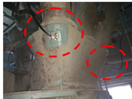
バイブレーターの設置
