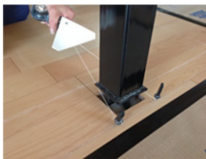
間仕切壁などの幅に合わせて、2本墨糸をセット
