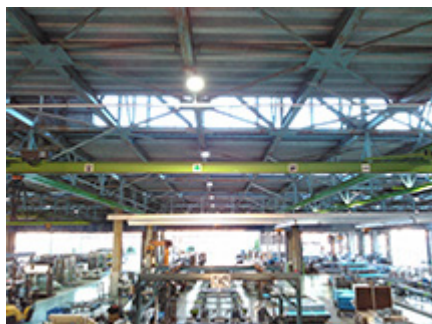
照明のLED化(第1組立工場)
