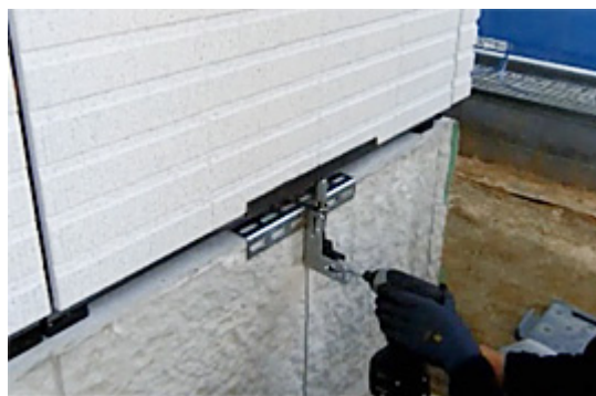
基礎と外壁の間に治具を取り付け、充電ドライバーを回転させることで、外壁の上下調整が可能
