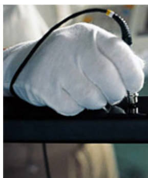
鉄骨の防錆塗装厚検査。 厳密に精度を確認
