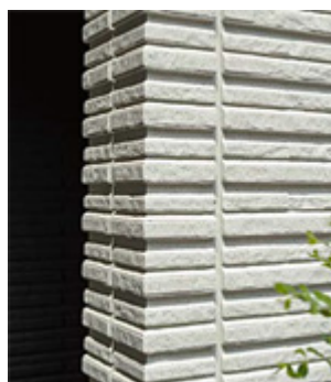
柄の工夫と生産技術の向上により、直角に近いシャープな出隅コーナー部のデザインが可能に
