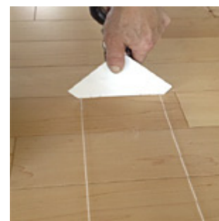
間仕切幅に合わせて、押さえプレートの切り込みに糸をセットし、墨打ち
