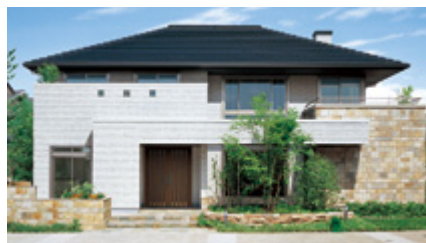
「省エネ・防災住宅」のモデルハウスの建築 (明石展示場: 当時)
