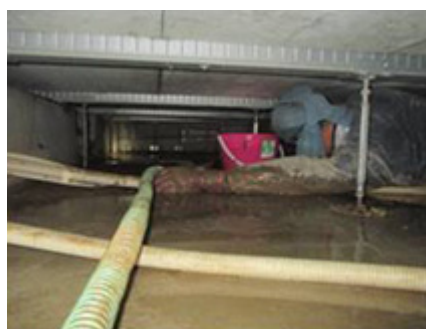
床下の汚泥かき出し作業
