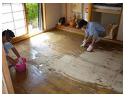
和室の畳を上げて下地から拭き上げ
