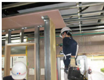
「内装施工コース」修了実技試験
