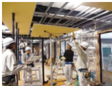
内装組立技能者を育成する「内装課程」の天井石こうボード施工実習
