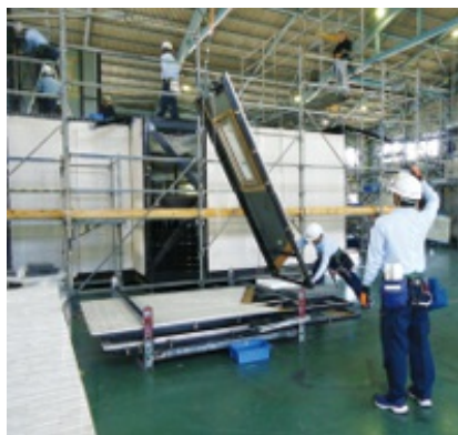
外装組立技能者・施工管理者を育成する「普通課程」の2階複合外壁施工(玉掛け)実習
