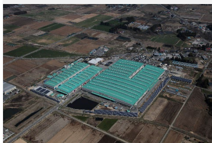
Tohoku Factory mega solar
