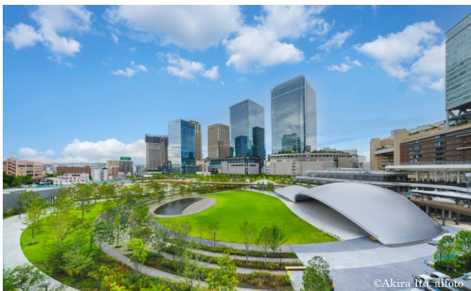
グラングリーン大阪南館からのうめきた公園・北館の景色
