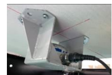
図4 ALCパネル下面の振動測定状況
