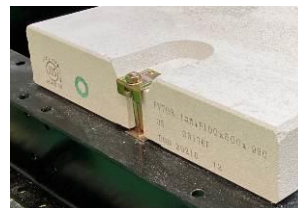
図1 ALCパネルと取付け金物
