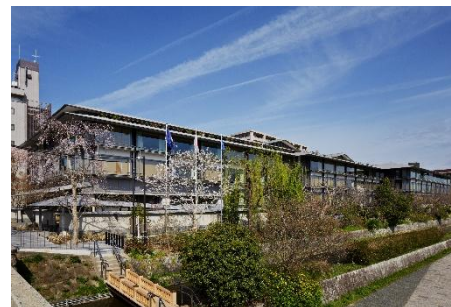
ザ・リッツカールトン京都 (京都市中京区)
