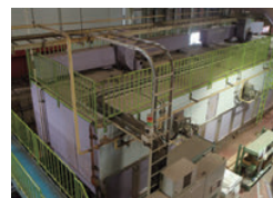
乾燥炉扉の外張り断熱
