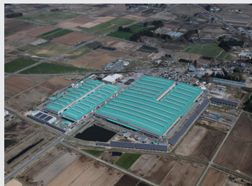
Tohoku Factory mega solar
